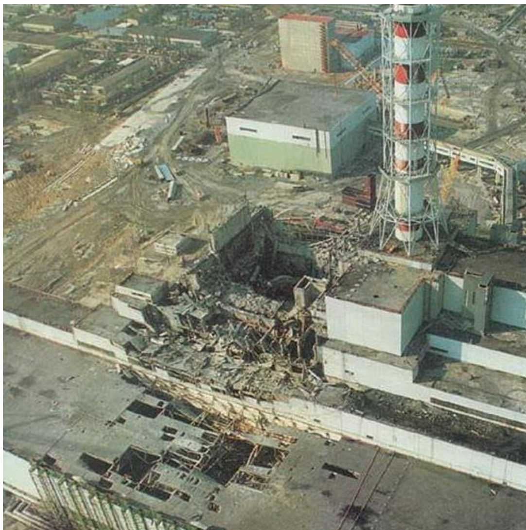
Разрушенный четвёртый энергоблок ЧАЭС в 1986 году. Фото: Wikipedia.org.
